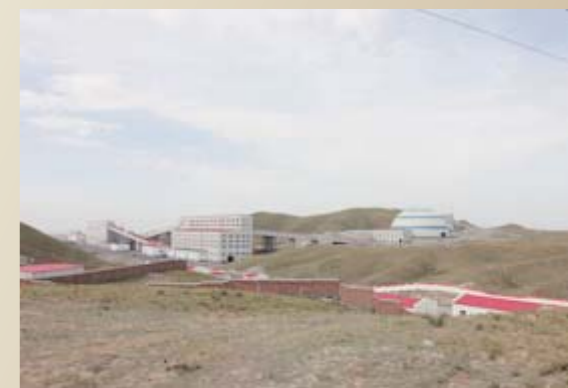
内蒙太平二期破碎站及储矿仓全景
