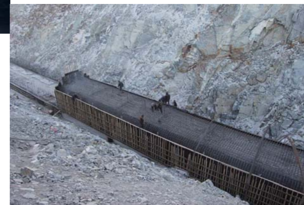
扩建工程施工中的1#皮带廊
