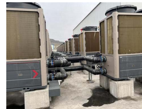
內蒙古太平安裝空氣能熱泵
