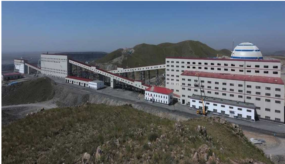
新建成的破碎站
