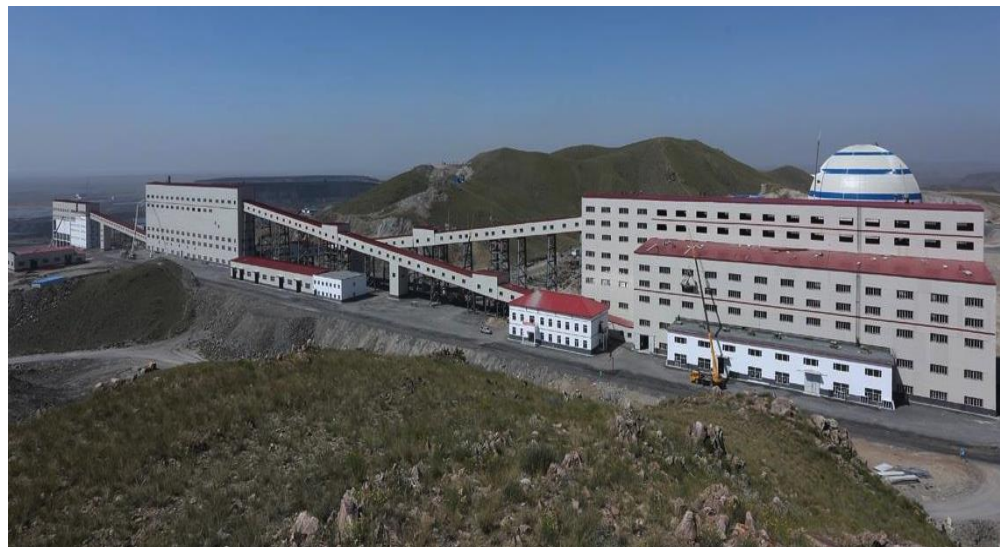
新建成的破碎站
