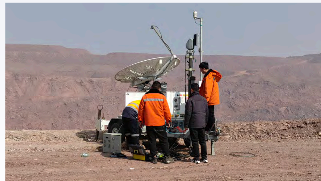
內蒙古太平救援隊緊急架設設備
