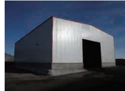
內蒙古太平公司新建煤棚，減少粉塵影響
