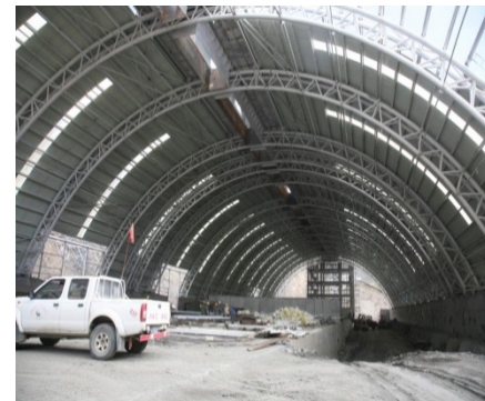
❖ 建设中的原矿堆场
