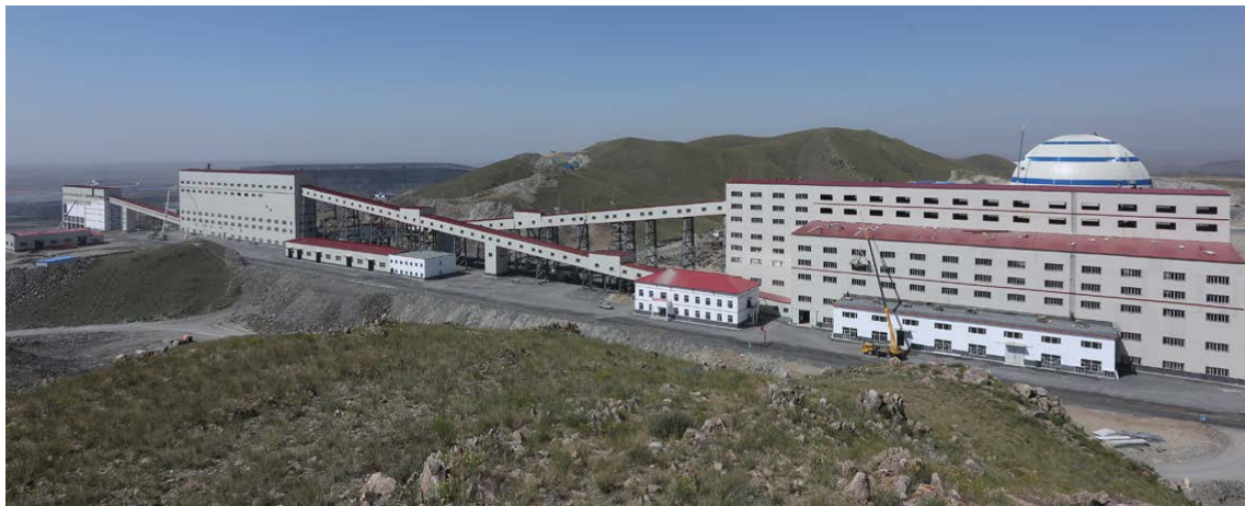
❖ 新落成的30,000吨破碎系统全景。
