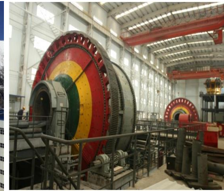
❖ 主要设备已安装
