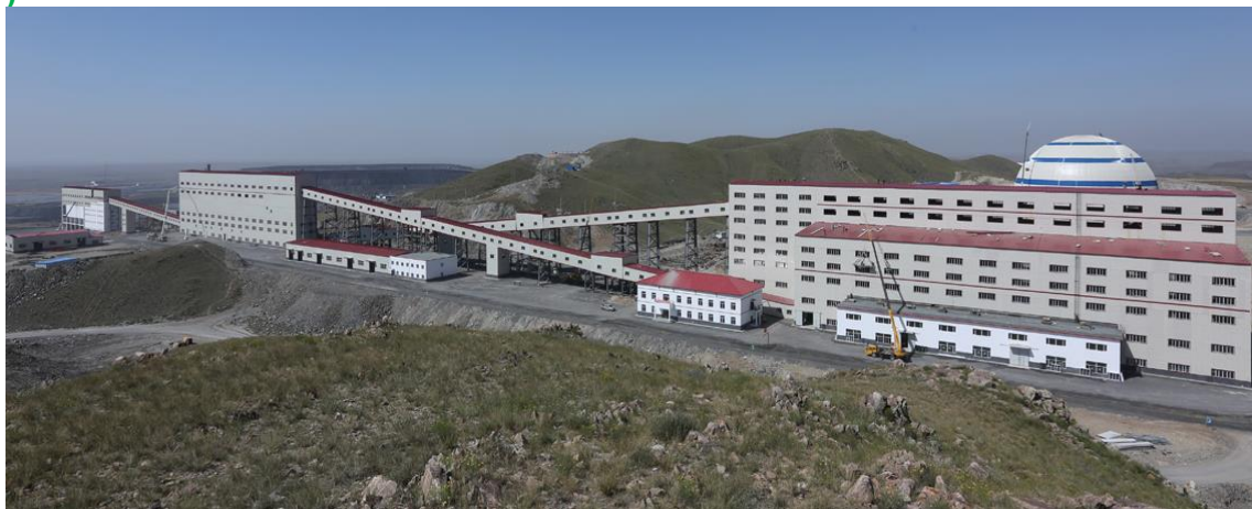
❖ 新落成的30,000吨破碎系统全景。
