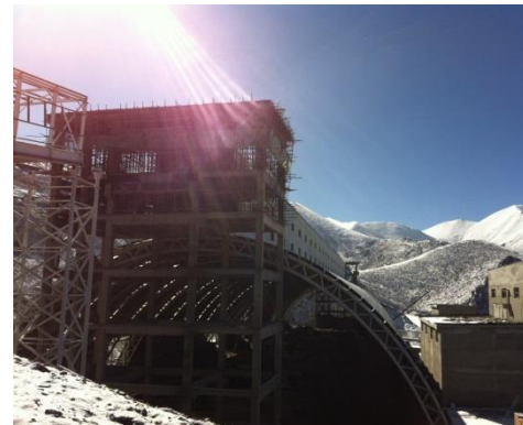
❖ 建设中的储矿仓
