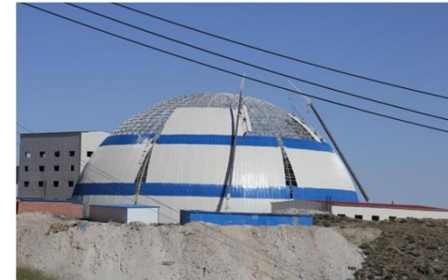
❖ 储矿仓：施工即将完成
