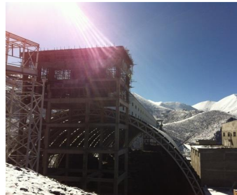
❖ 储矿仓建设即将完成
