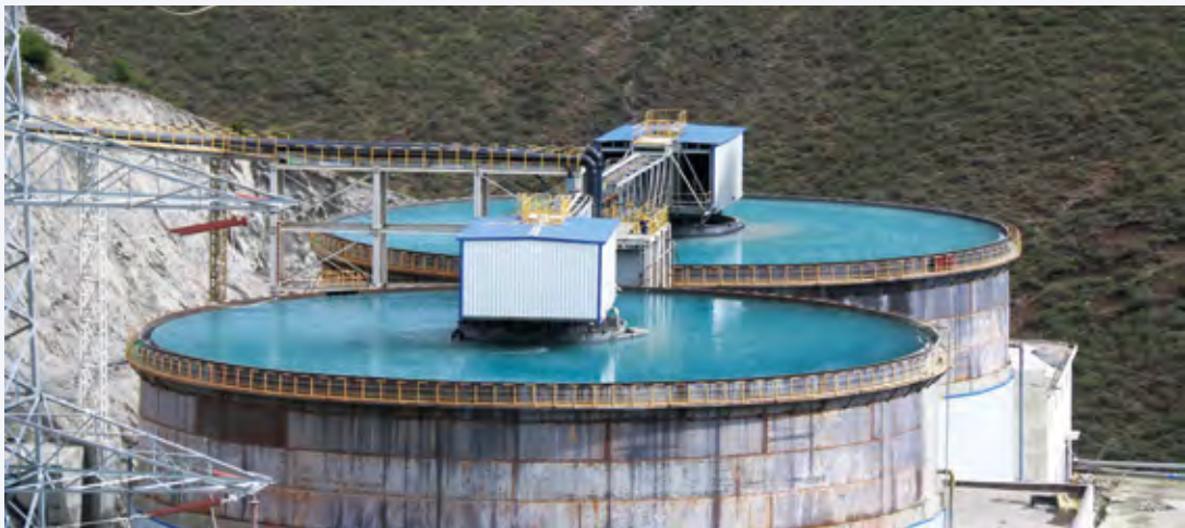
西藏華泰龍新建設備
