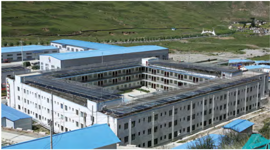
華泰龍公司鋪設1.5萬平方米太陽能進行無煙礦區建設
